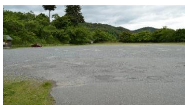
公園グラウンド駐車場
